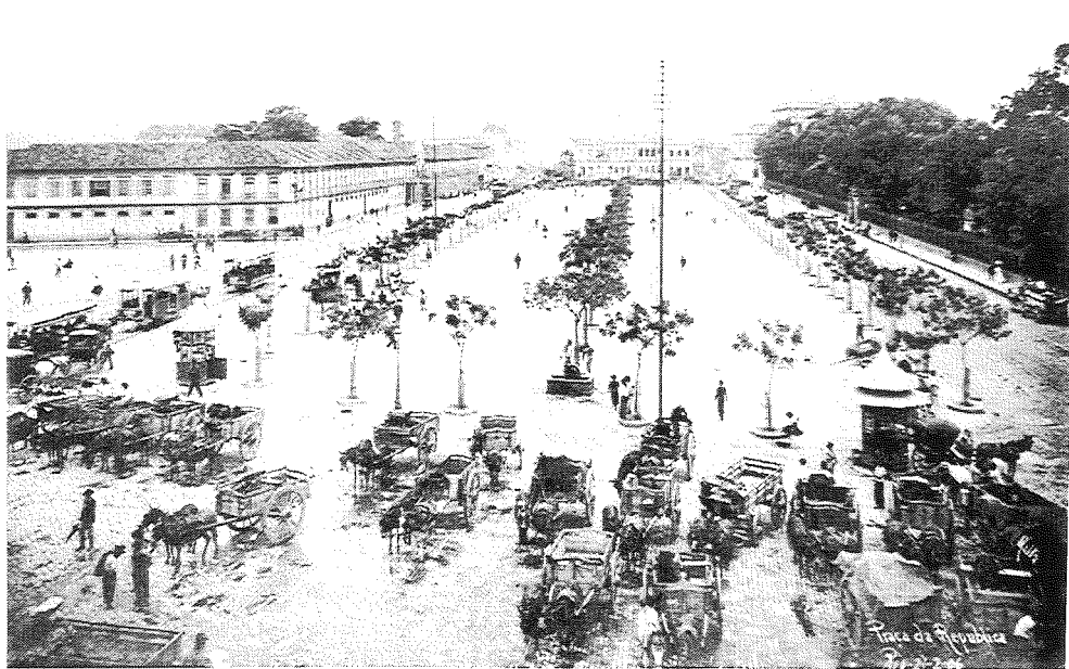
O Campo de Santa Anna no início do século: da sua origem portuguesa, ele guarda de um lado a característica de espaço amplo e aberto com seus usos tradicionais (espaço de passagem e de encontro dos condutores de bonde, dos carroceiros e dos carregadores de água). De outro, ele se transforma em lugar de passeio, de retiro e tranquilidade. Surge a Praça da República, jardim à inglesa, onde predominam a vegetação tropical e as grades que separam o campo do jardim idílico. Foto de Augusto Malta, 1905.
